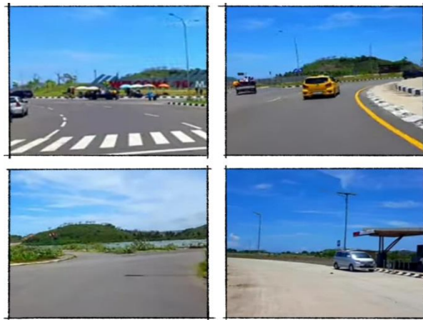
Gambar 7. Akses Jalan Menuju Pantai Tanjung Aan (Sumber: dokumentasi pribadi, 2023)
